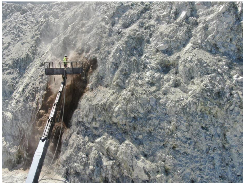
Рисунок 2.9 – Процесс торкретирования после установки сетки
